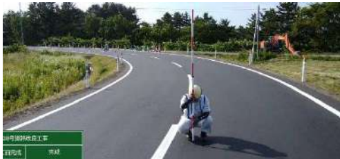
完成（取付県道舗装）
