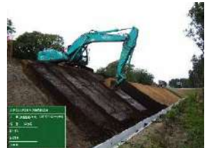
法面整形(ICT)
