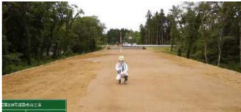
完成（本線土工）
